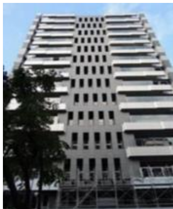
台北忠泰玉光 施工中
